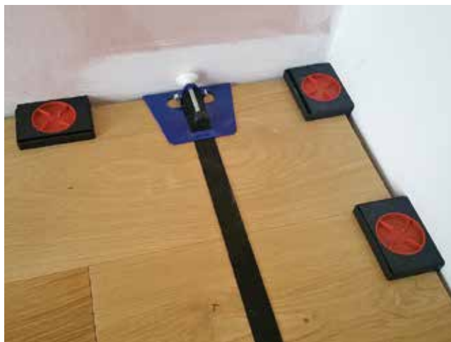
Správně – použití stahováký a dilatačních klínek, které se dají nastavit od 5–20 mm.
