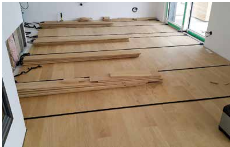
Správně – po nalepení dřevěnou podlahu stáhnout k sobě a zatížit.
