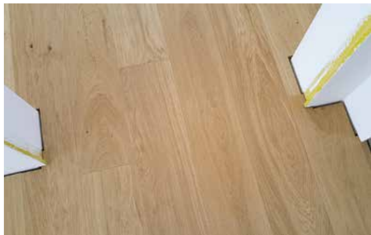
Správně zaříznutá podlaha pod zapuštěné zárubně.
