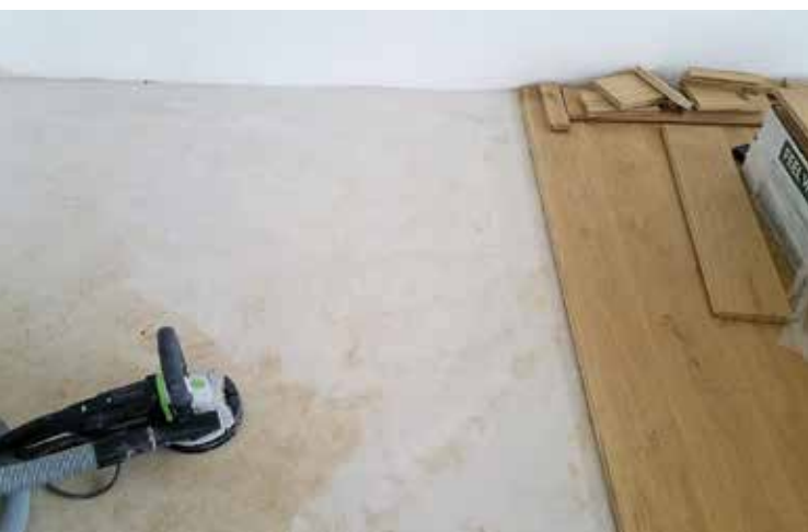
Správně – odbroušení nivelace před lepením dřevěné podlahy.
